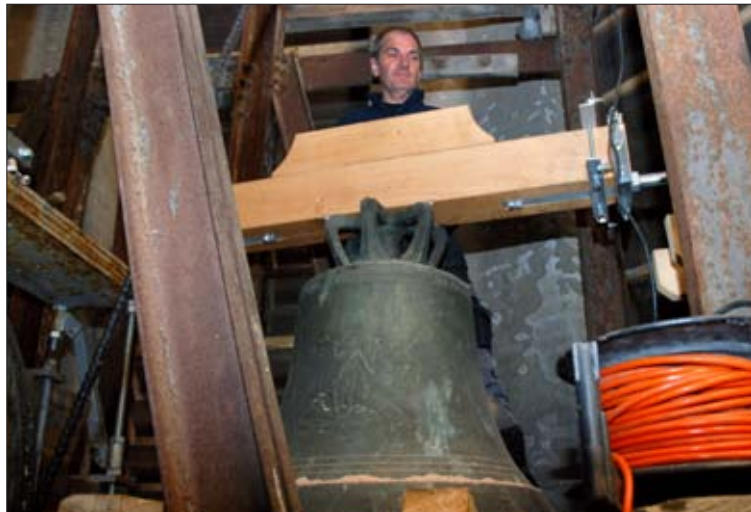
Alexander Lang hat mit seinem Kollegen drei Glocken von St. Nikolaus neue Holzjoche angepasst. Hier ist er mit der kleinsten Glocke zu sehen, die freilich auch noch über acht Zentner wiegt.
