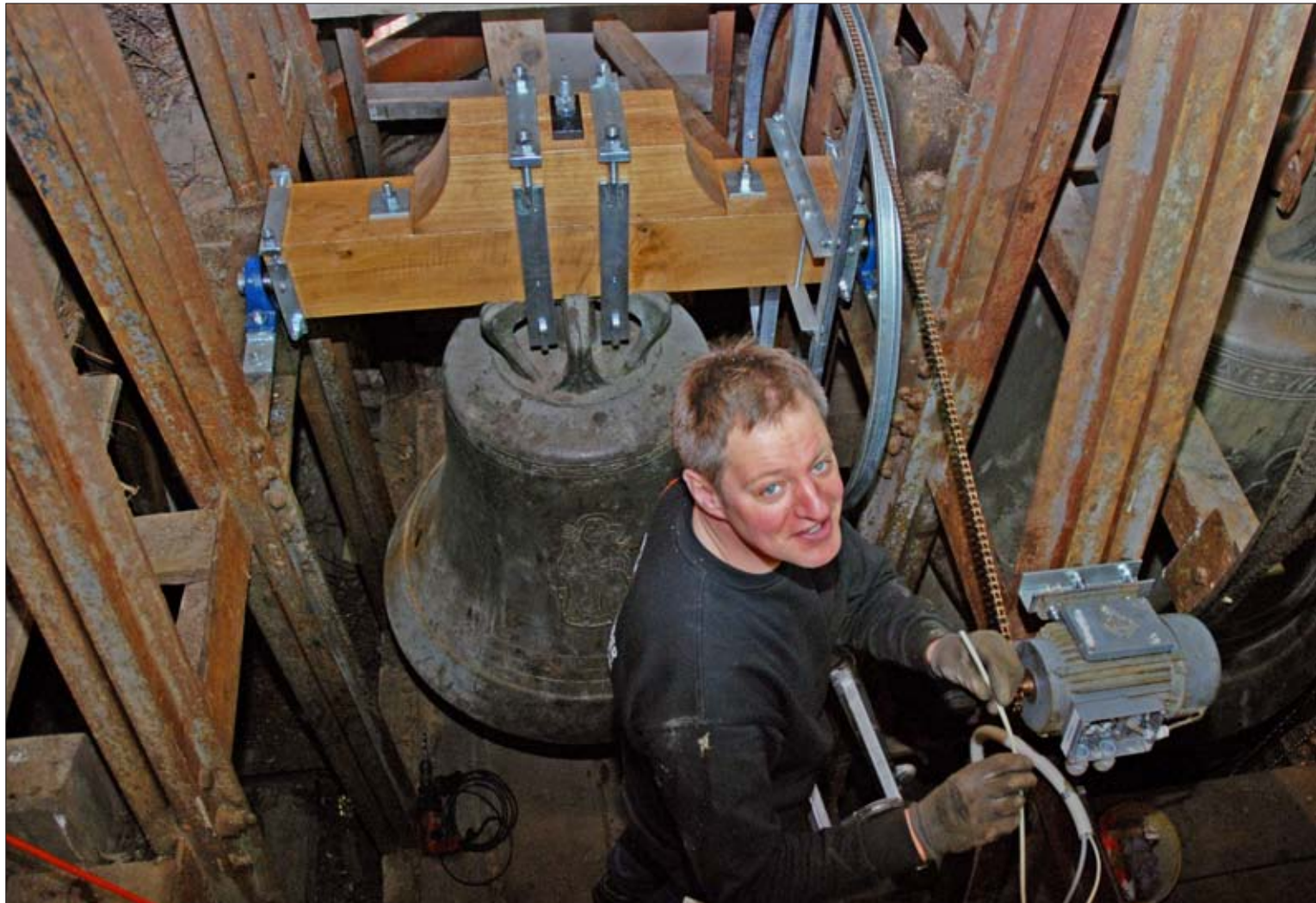
Stefan Gruber arbeitet am Antriebsmotor der 950 Kilo schweren Marienglocke. Im Zuge der Sanierung wurden auch die Läuteräder ausgetauscht, über die die Glocken zum Schwingen gebracht werden. – Fotos: Schlenz
